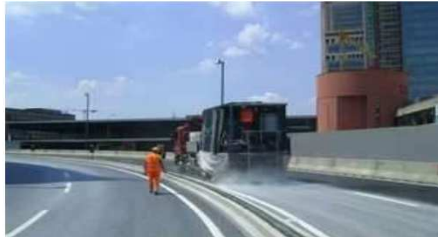
Trattamento antimogg cemento autostrade
